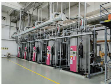
奥鸿药业锅炉改造
