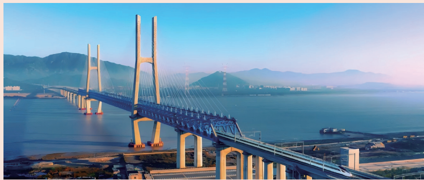
杭绍台高铁椒江特大桥
